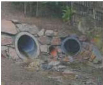
Wasserbausteine gleichen den Übergang aus. Foto: Ingenieurbüro Halbauer
