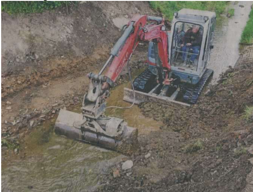
Die Bauarbeiten an der Brücke zur Firma Volger laufen auf Hochtouren. Foto: Tobias Schubert
