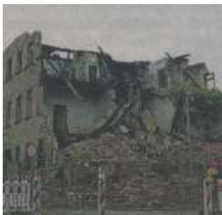
Das ehemalige Freia-Gebäude, das nun abgerissen wird. Foto: Dieter Eckold
