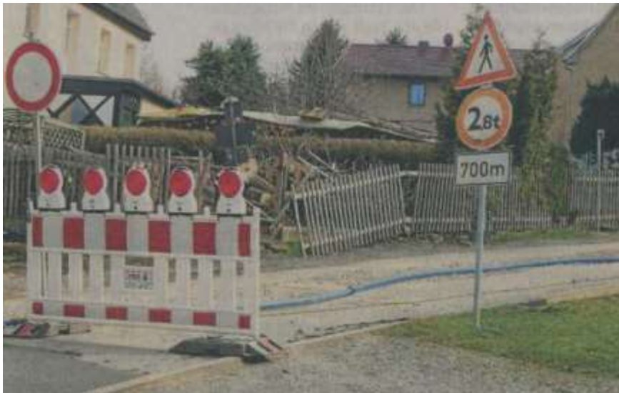
Die Baustelle der Taweg in der Reichenbacher Straße in Teichwolframsdorf. Archivfoto: Tobias Schubert
